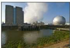
4 - Chinon A Indre-et-Loire, à 45 km de Tours 3 réacteurs UNGG Mises en service 1963, 1965 et 1966 Dates d'arrêt : 1973, 1985 et 1990
