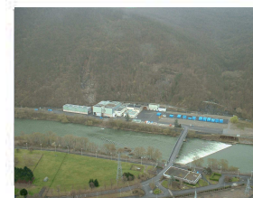
1 - Chooz Ardennes, à 60 km de Charleville-Mézières Réacteur à eau pressurisée Mise en service : 1967 Date d'arrêt : 1991
