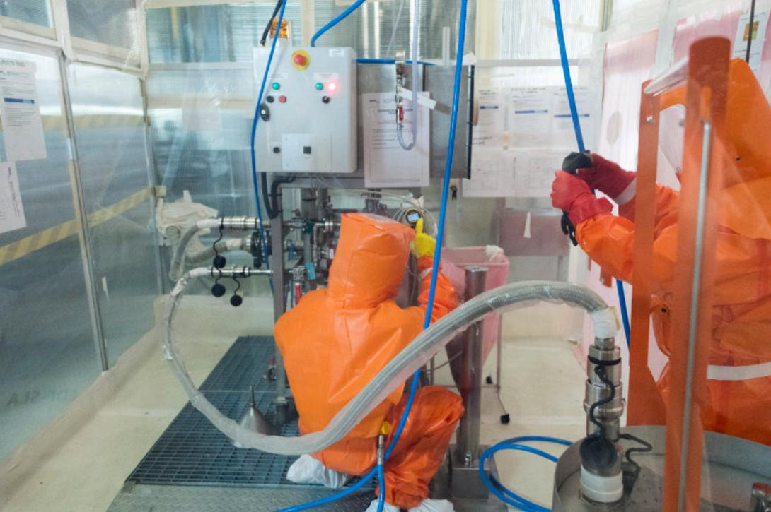
Figure 4. Centrale nucléaire de Saint-Laurent-des-Eaux - Sas de confinement pour un chantier - opération de vidange d'une cuve des effluents liquides contaminés Alpha. (Crédit : Laurent Zylberman/Graphix-Images/Médiathèque IRSN)
