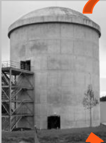
VERCORS Maquette d'enceinte échelle 1:3 Site EDF R&D des Renardières Inauguration en 2016
