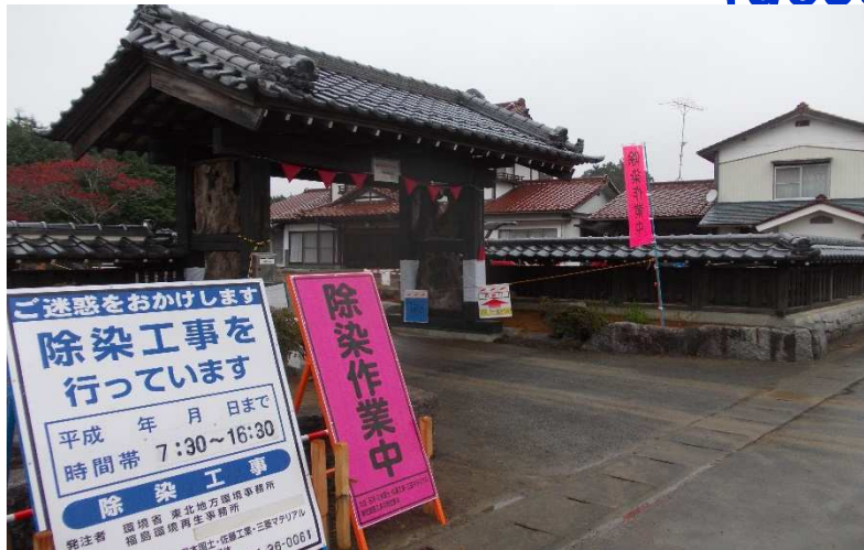
« Exemple de chantier visité par la mission sécurité civile : novembre 2014 »
