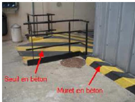
Seuil / muret béton
