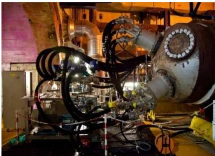
Retrait de 15 micromètres d'oxydes du faisceau tubulaire
